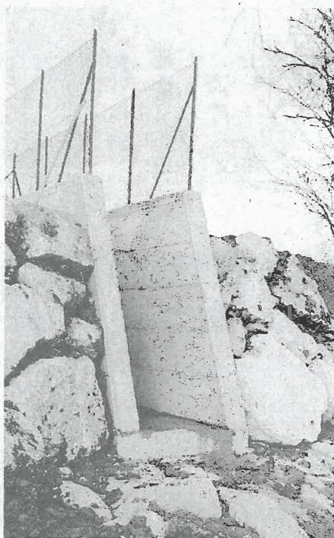
Un tratto del canale anti allagamenti realizzato a Locate
