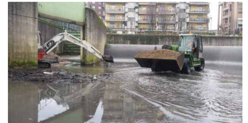
Intervento di pulizia sullo scolmatore del torrente Morla nel fiume Serio nel quartiere Campagnola di Bergamo
