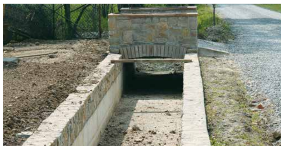
Piano di sviluppo rurale della Regione Lombardia 2007/2013. A sinistra il rifacimento di un ponte in pietra e mattone della Roggia Patera in Calcinante e a destra la sistemazione del fondo Roggia Nuova in comune di Zanica.
