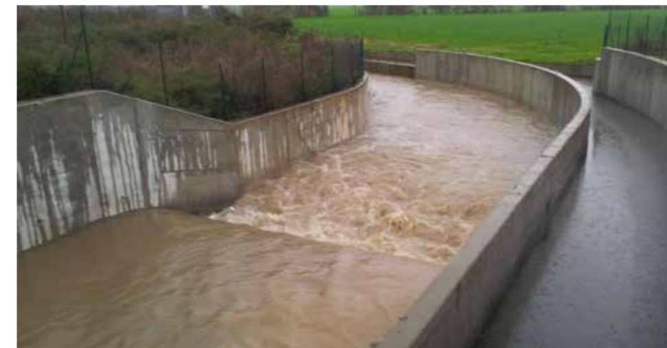
Canale Gronda Sud in piena a Lurano, nella pianura bergamasca. A fianco si scorge la Roggia Brembilla.
