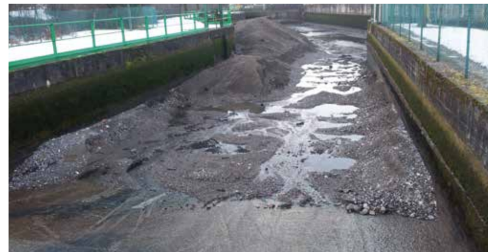
Pulizia della vasca di carico all'opera di derivazione Rogge originate dal fiume Serio in Albino
