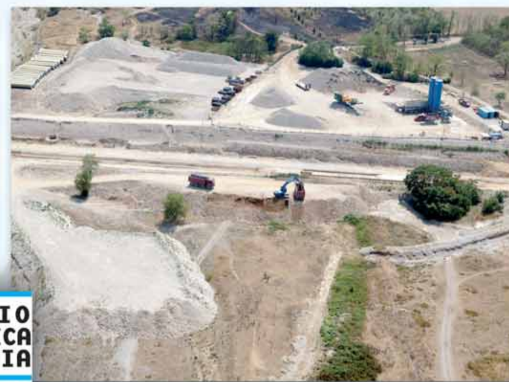
La ripresa aerea dei lavori lungo il tratto Serio-Cherio
