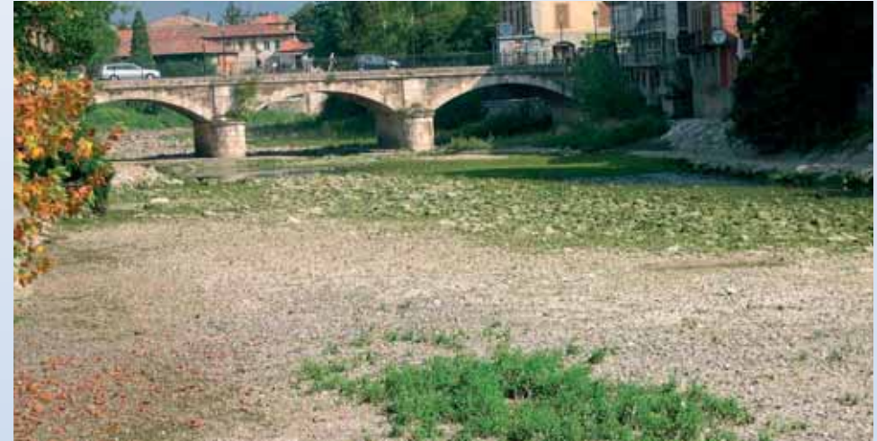
Il fiume Serio al ponte vecchio di Seriate (via Italia)
