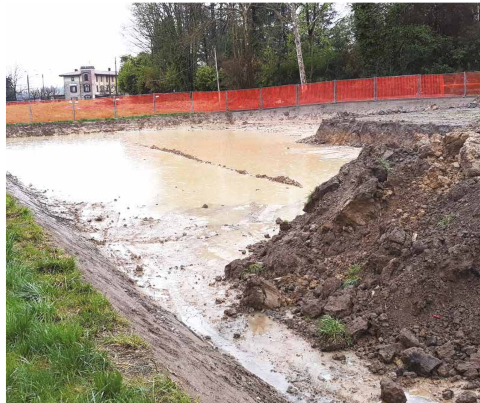
Nelle due foto una fase delle operazioni per lo scavo di bonifica dell'appezzamento di terreno su cui verrà successivamente realizzata la vasca di "laminazione"
