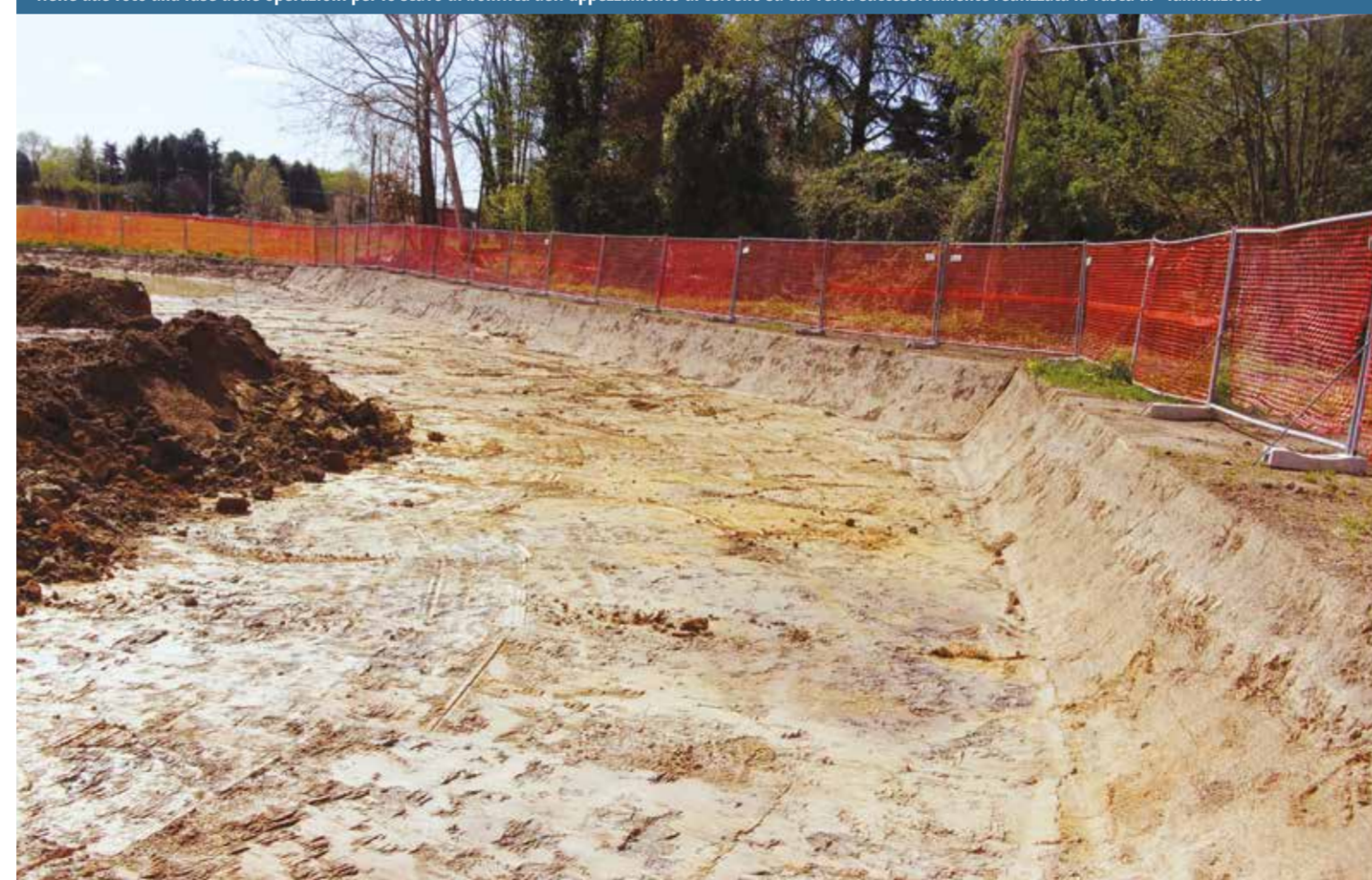
Nelle due foto una fase delle operazioni per lo scavo di bonifica dell'appezzamento di terreno su cui verrà successivamente realizzata la vasca di "laminazione"
