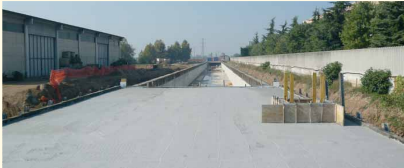
La soletta di copertura del Gronda Sud
