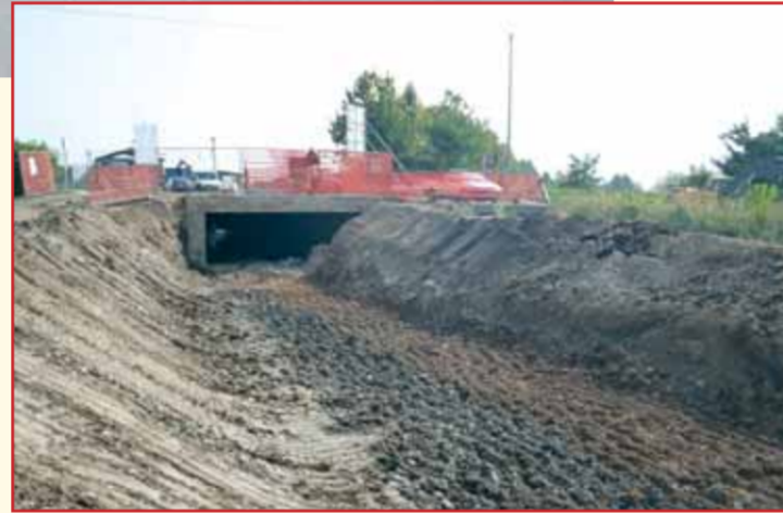
L'imbocco del canale sotto la Strada Provinciale 121
