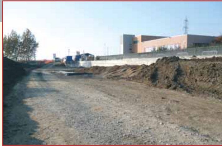
La strada di accesso al cantiere
