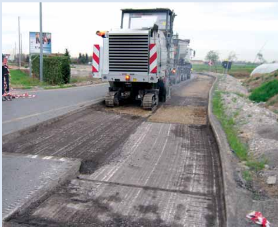
I lavori sulla provinciale 121
