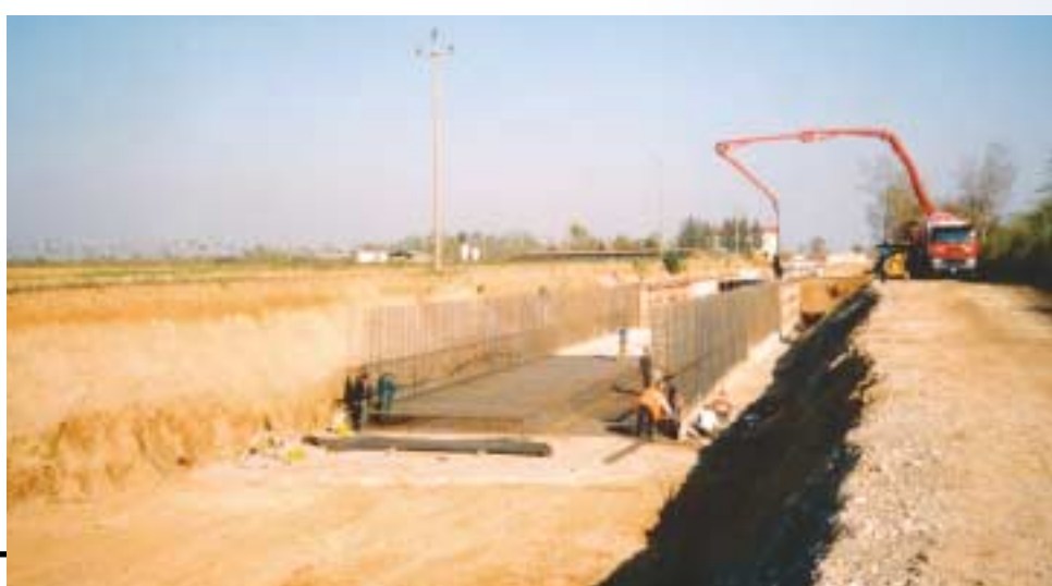
Lavori di costruzione del Canale di Gronda Sud in Lurano
