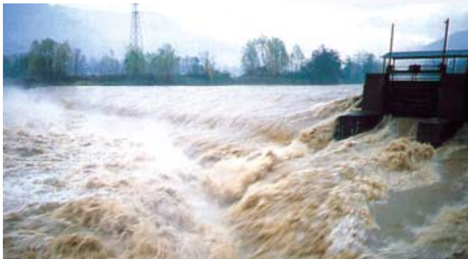
Il fiume Serio in piena nei pressi dell'opera consortile della Roggia Borgogna a Villa di Serio
