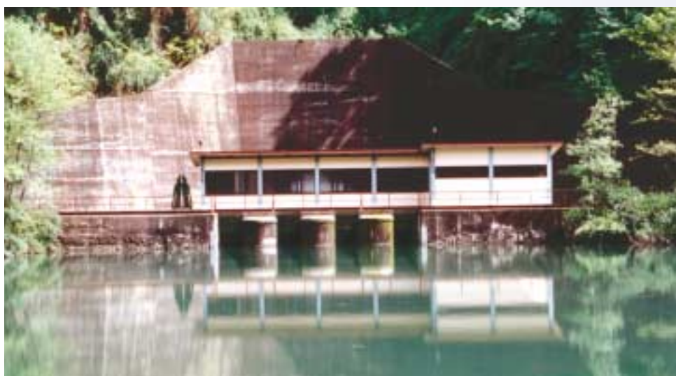
Opera di presa del canale irriguo Adda-Oglio derivato dal fiume Adda in Calusco
