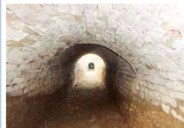
Pulizia voltino sottopasso ferroviario in comune di Romano di Lombardia
