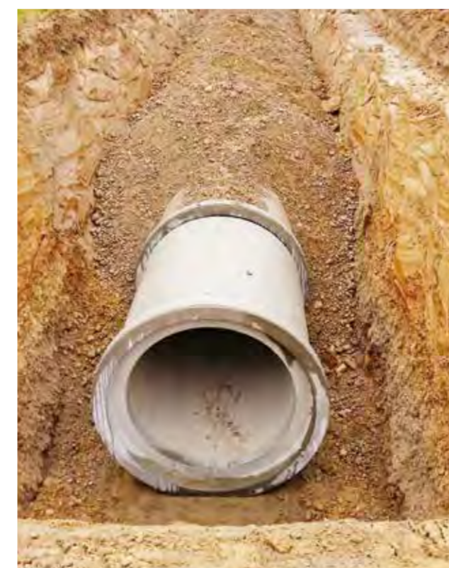
Posa di un tratto di roggia intubata presso località "Portico" in comune di Romano di Lombardia
