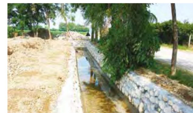
Canalizzazione mediante realizzazione di muri in pietra in prossimità di "Via delle Scarpe" in comune di Martinengo
