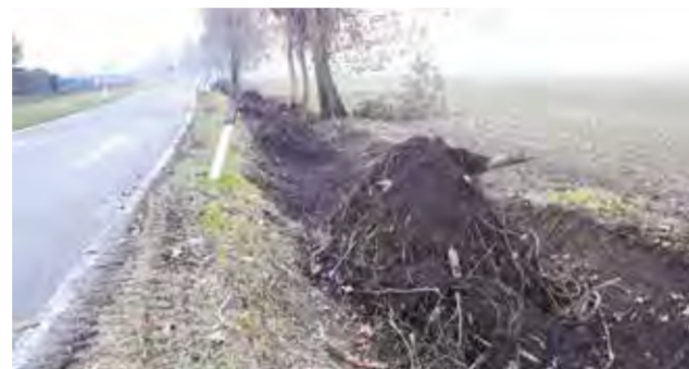
Operazioni di pulizia e risagomatura alveo in comune di Ghisalba lungo il lato ovest ex S.P. n. 96
