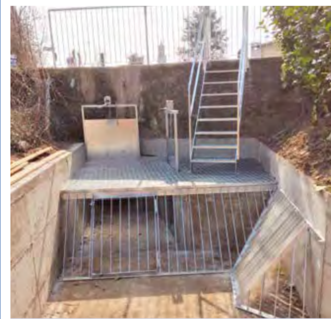
Realizzazione nuovo manufatto di regolazione in comune di Martinengo
