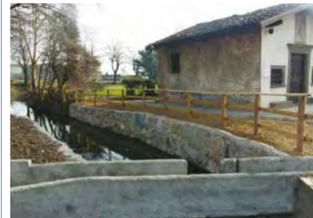
Interventi di ripristino della roggia Martinenga, ripristino tratto adiacente alla chiesetta San Rocco in comune di Martinengo
